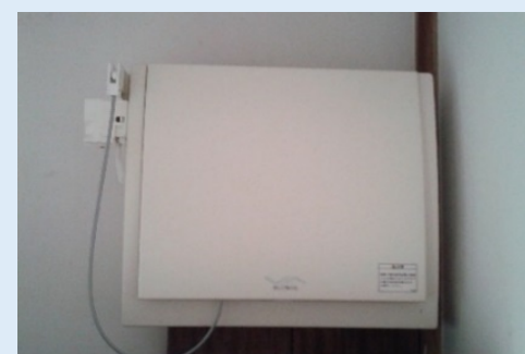
◇ヤモリ・デ・リモート利用で「ヤモリ」本体を分電盤側面部に設置したケース
