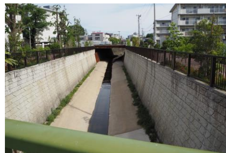
妙正寺川河川改修（若宮地区）
