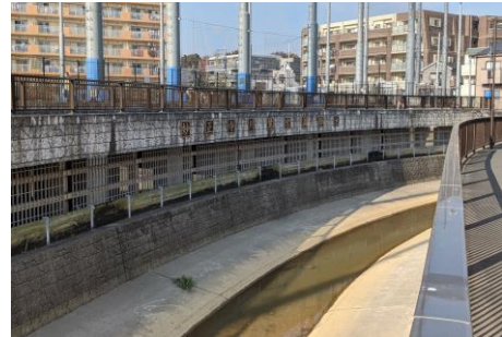
妙正寺川鷺宮調節池
