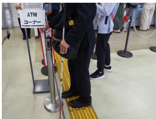
誘導用ブロック脇のポール
