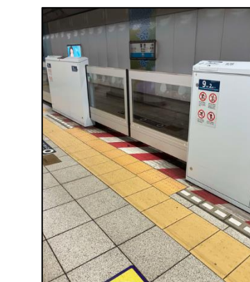
視覚障害者誘導用ブロック*（落合駅）
