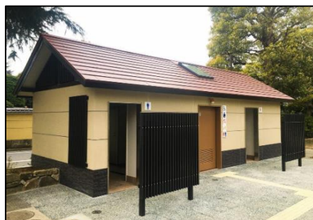
バリアフリートイレ* (新井薬師公園)
