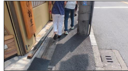
【幅員の狭い歩道】
