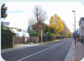
拡幅された道路▶
