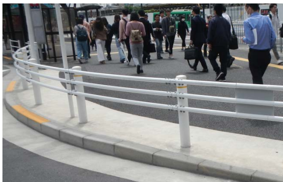
ガードパイプ
