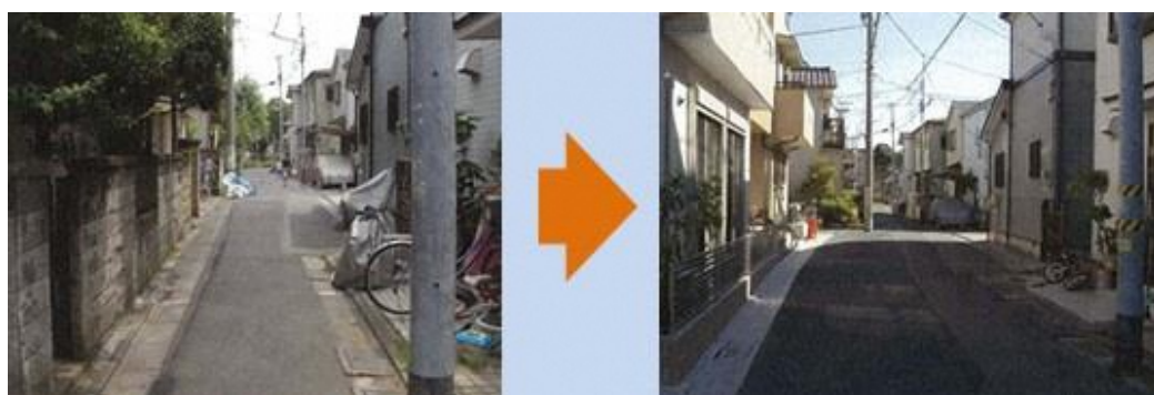
写真 避難経路整備の例
