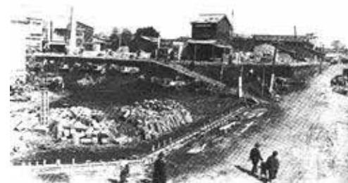
駅前の掘り下げ工事風景
