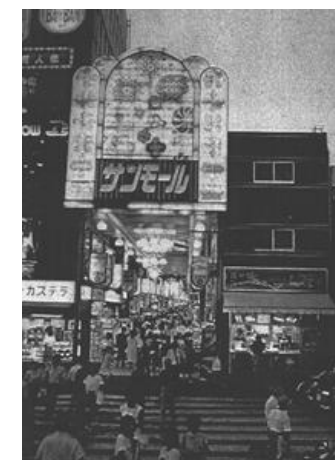
昭和33年 トネル式アーケード完成
