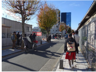
歩道が狭く、すれ違いが困難な様子
