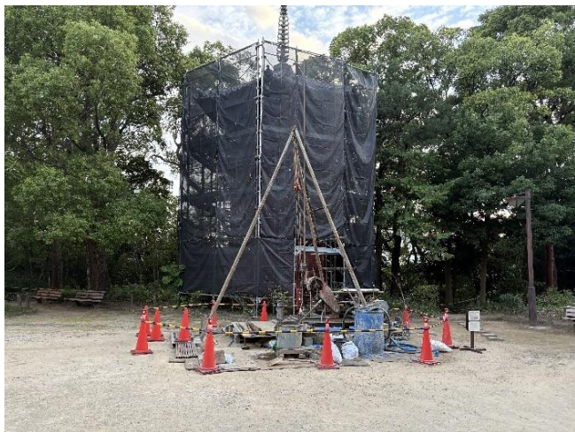
写真3 地盤調査と足場組立状況
