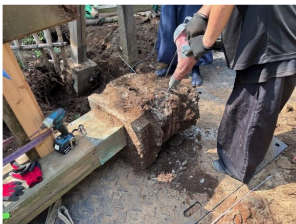
写真1 本柱抜き取り状況
