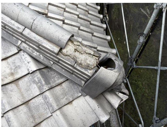
写真5 瓦の欠損
