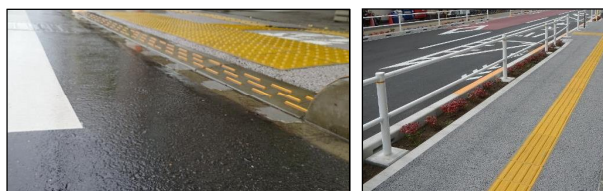
歩道の段差改善や視覚障害者誘導用ブロックの整備（新井天神通り）
