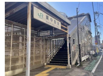
改札階までのエレベーターがないので設置をして欲しい
