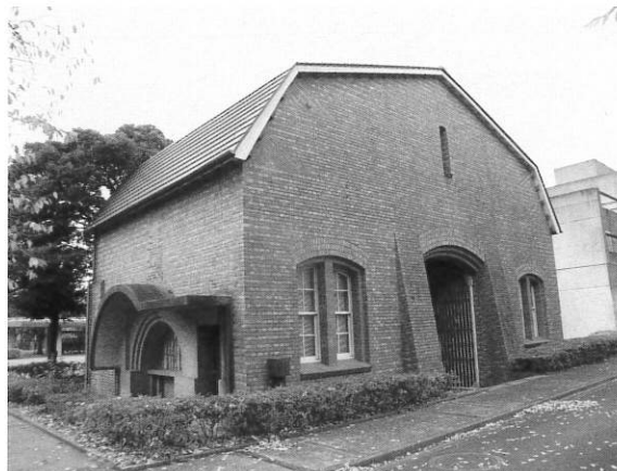
写真3 北側から見た旧豊多摩監獄表門 写真の左側に、「元守衛室」東側に設けられた 新たな出入り口と庇のついた受付が見える
