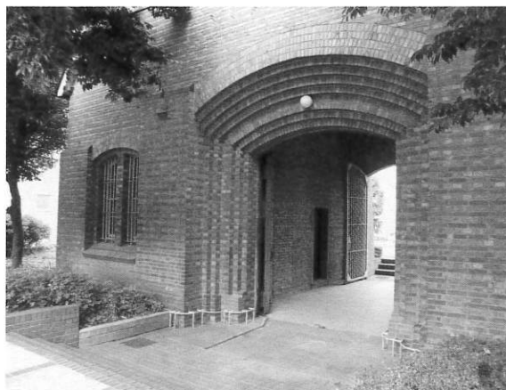
写真5 旧豊多摩監獄表門南面入口
