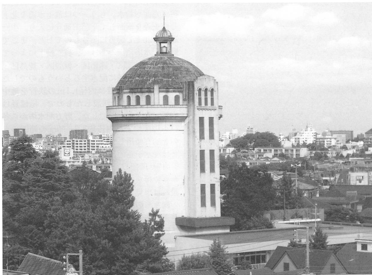
野方配水塔（南西方向から）
