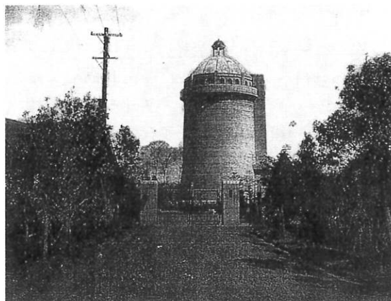
竣工直後の状況（現新青梅街道方向から北を望む） （1931「荒玉水道誌」より）
