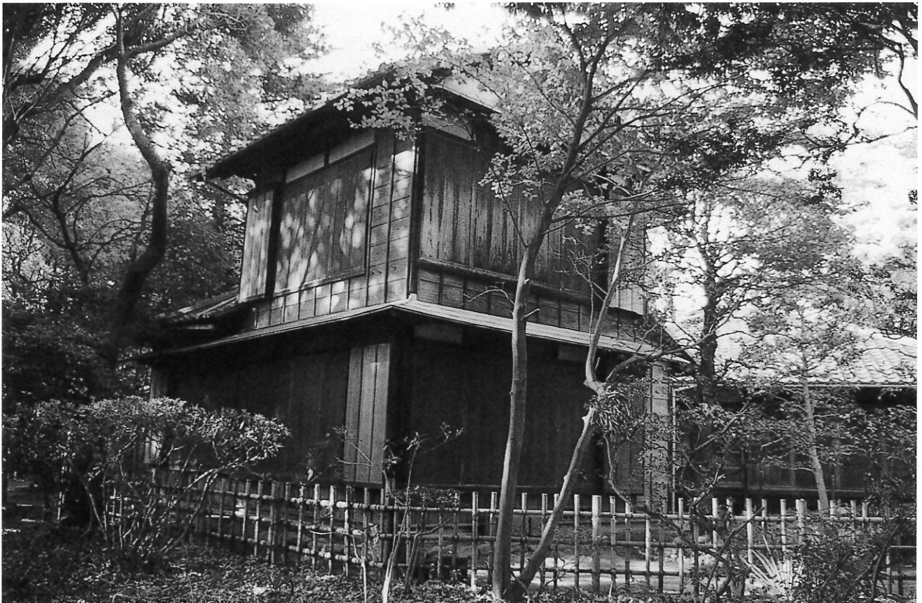
哲学堂 鬼神窟（中野区指定文化財）：大正2～4年（1913～15）に建てられた接待・休憩を目的とした建物で、大正時代の住宅建築の様式を取り入れたものです。
