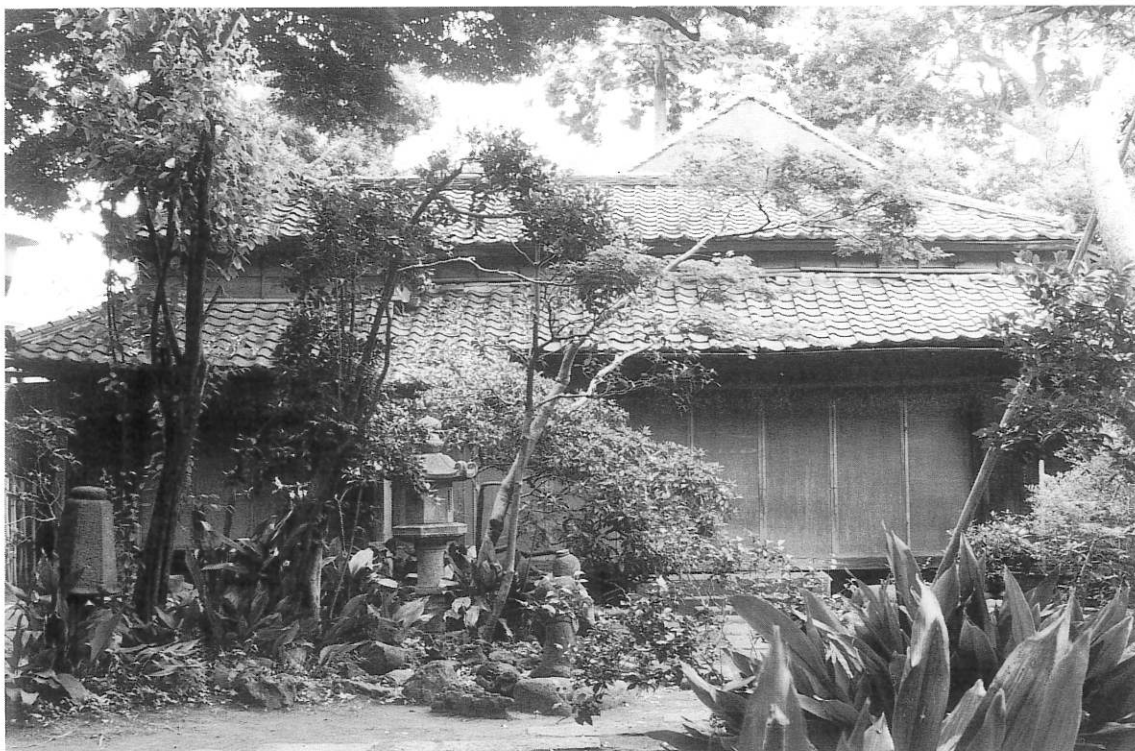
▲山崎家茶室・書院現状（南側から見る）
