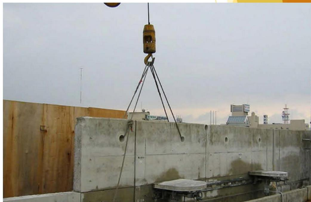
⑤切断後レッカーにより吊り上げ、**地上でコンクリートを粉砕し搬出**
