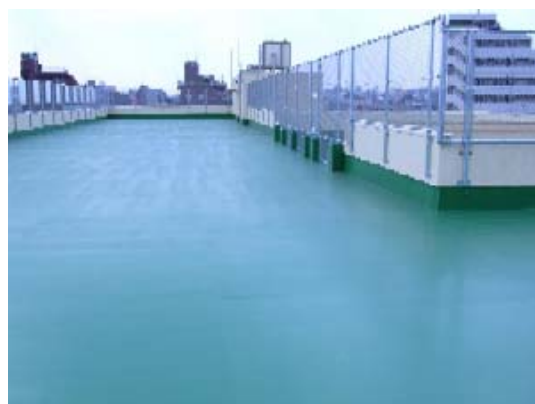
防水とフェンス改修した屋上
