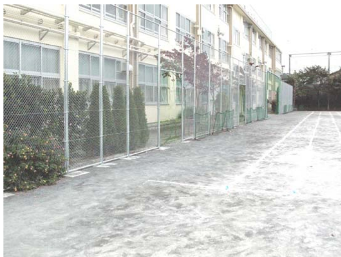
校舎前に防球フェンスが設置されました
