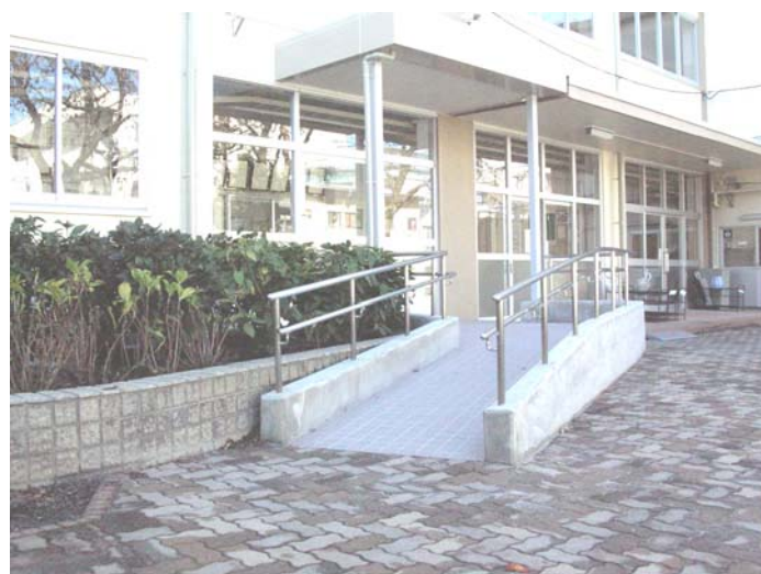
正面玄関横にスロープが設置されました
