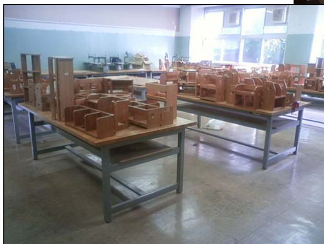
第二技術室：床を改修し空調を取り付けます
