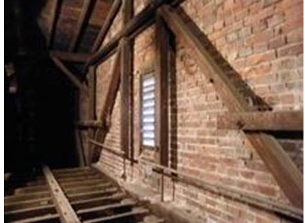
写真10 天井裏小屋組（裏面西側）
