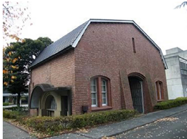
写真2 裏西側（北東側から）
