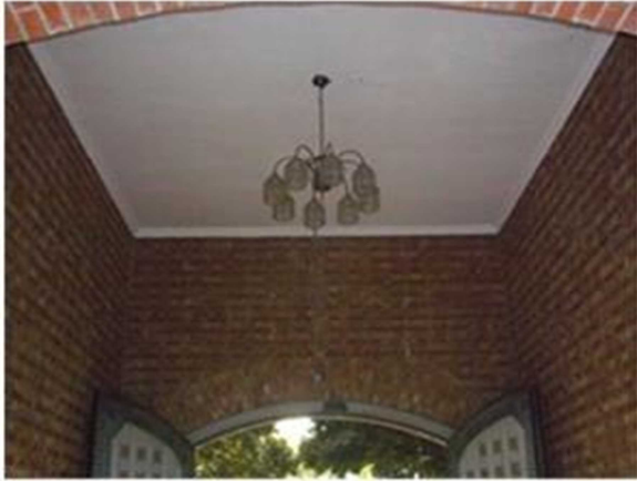
写真7 中央通路天井部分（北側から）
