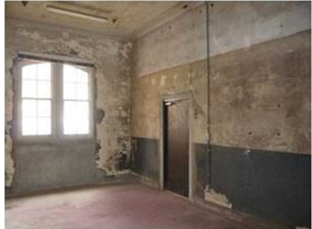
写真12 西側部屋内部（南側から）
