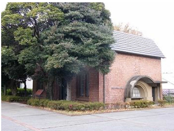
写真1 正面側（南東側から）
