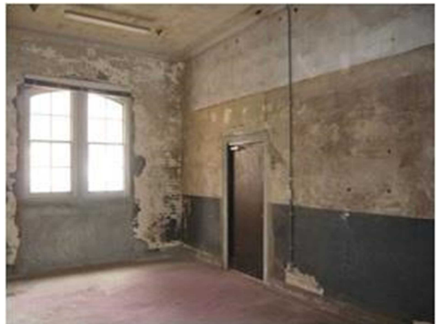
写真西側部屋内部（南側から）
