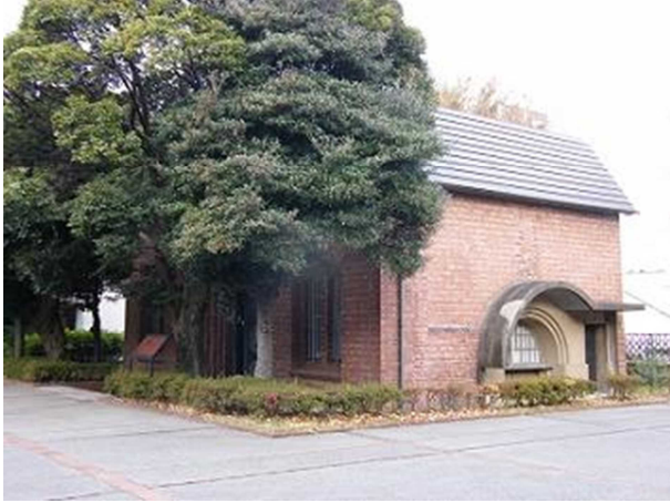
正面側（南東側から）
