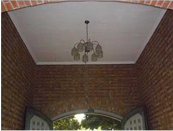
中央通路天井部分（北側から）
