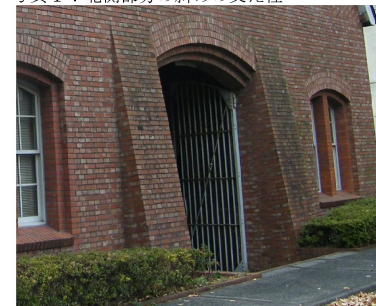
写真1：北側部分の斜めの支え柱
