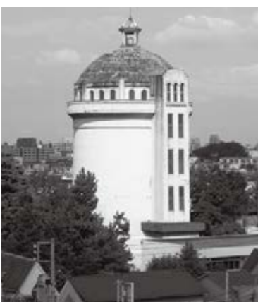
外壁には空襲時の弾丸の傷跡が残されています
